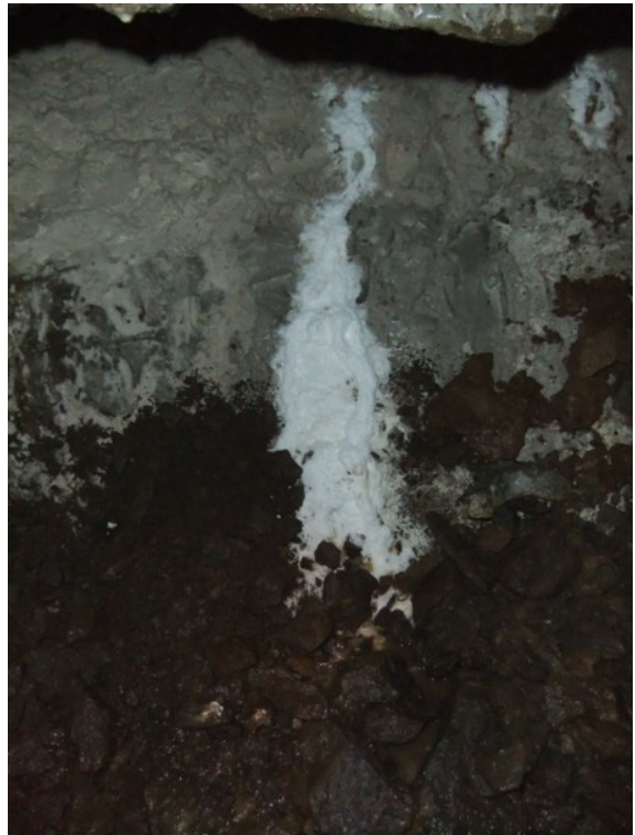
(21) (22) 水の流れによって溶け出し 鍾乳石のようにになっている
