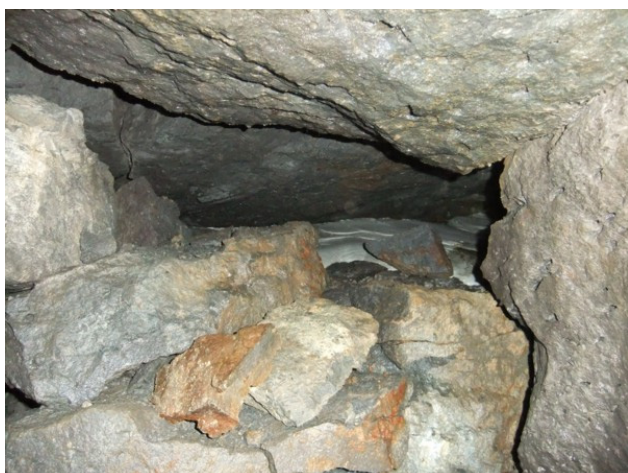
(15) (16) モルタルが流入して塞がれた早稲田支洞側を主洞から見る
