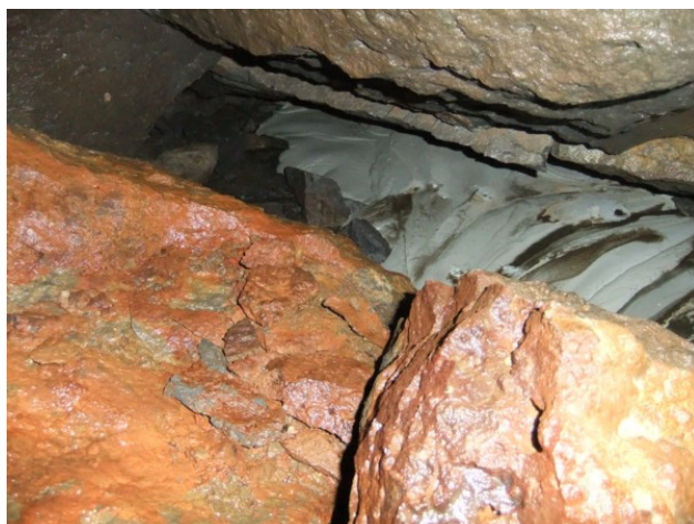
(15) (16) モルタルが流入して塞がれた早稲田支洞側を主洞から見る
